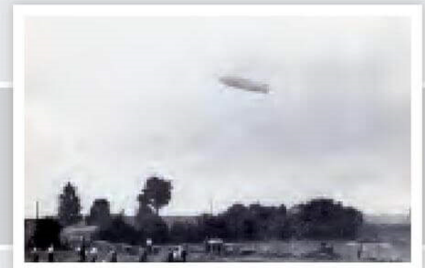
Luftschiff (Zeppelin) über am Deichbau beschäftigter Arbeiter im März 1934
